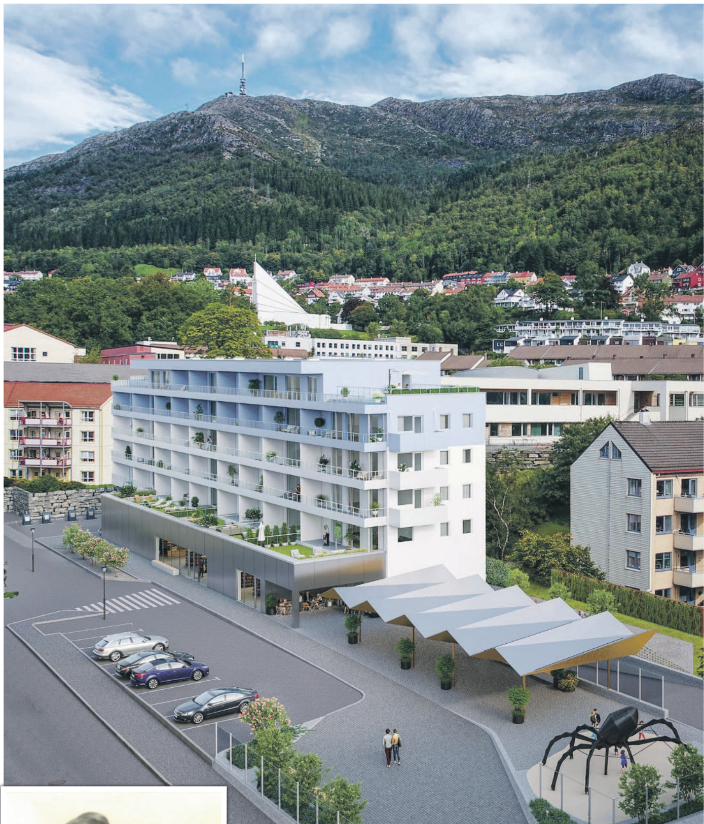
ERLEVEIEN: Det nye prosjektet i Erleveien på Landås vil se slik ut, når det står ferdig mot slutten av dette året og begynnelsen av 2023. Utbygger Vestbo har for øvrig byttet ut edderkoppene t.h. med en stor fugl - en erle, som og blir et lekeapparat. FOTO: VESTBO
