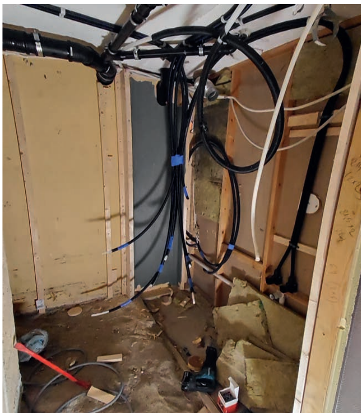
Alle avløpsstammer og vannledninger i boligselskapet er nå utskiftet.
